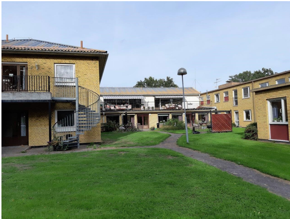
Kvillgården. Huvuddelen av byggnaden är i två våningar.
