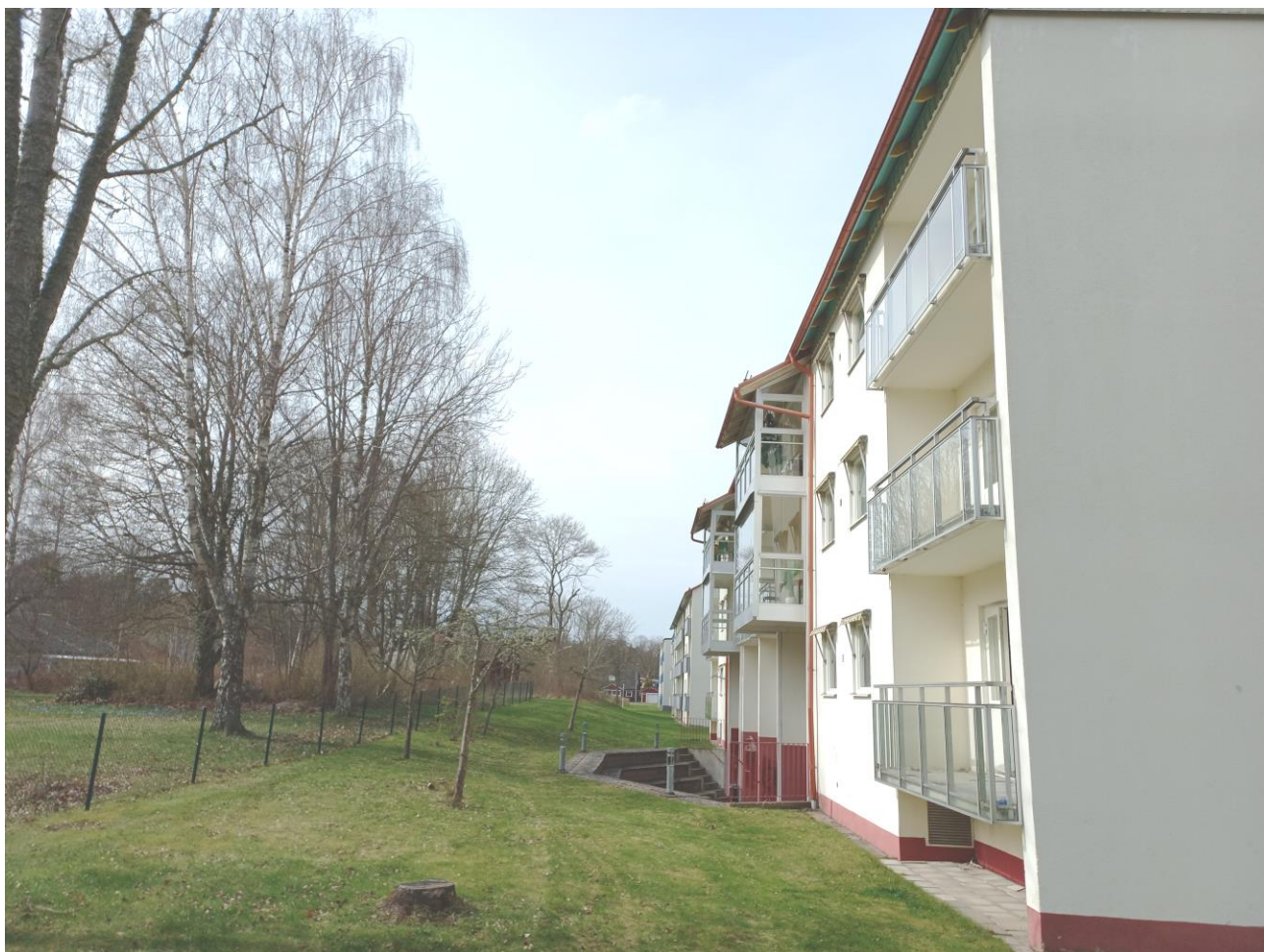
HLC-husets baksida mot kvarterets inre med trädunge.
