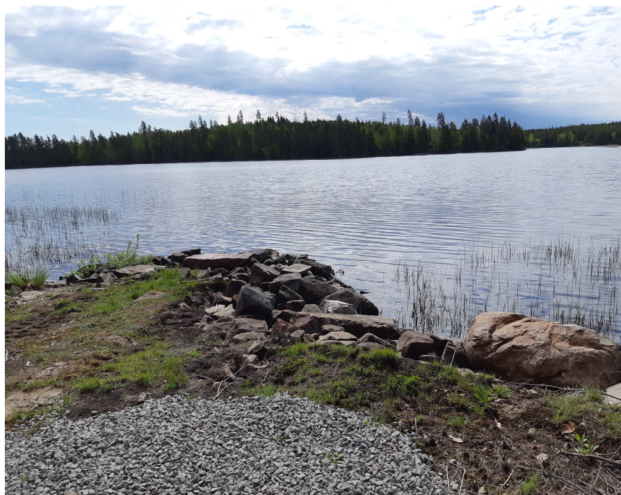
Befintlig stenpir, på vänster sida finns rester av en träbrygga.
