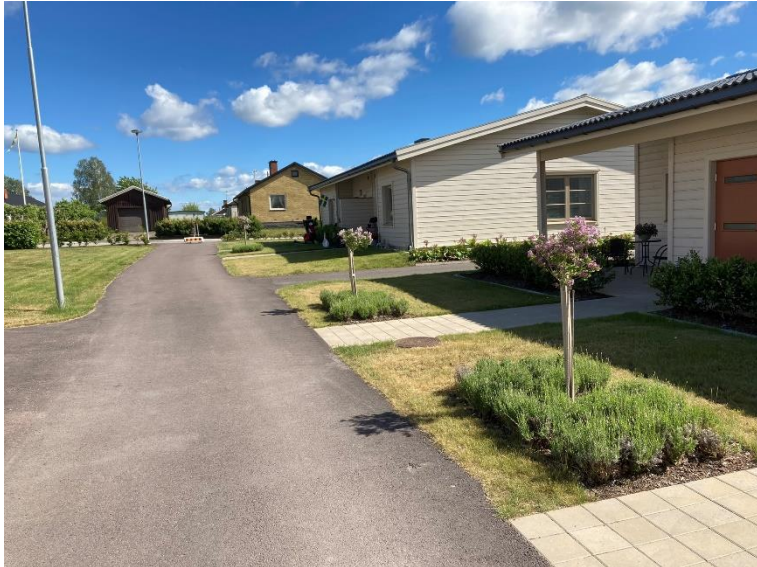
Nybyggda marklägenheter norr om järnvägsstationen.
