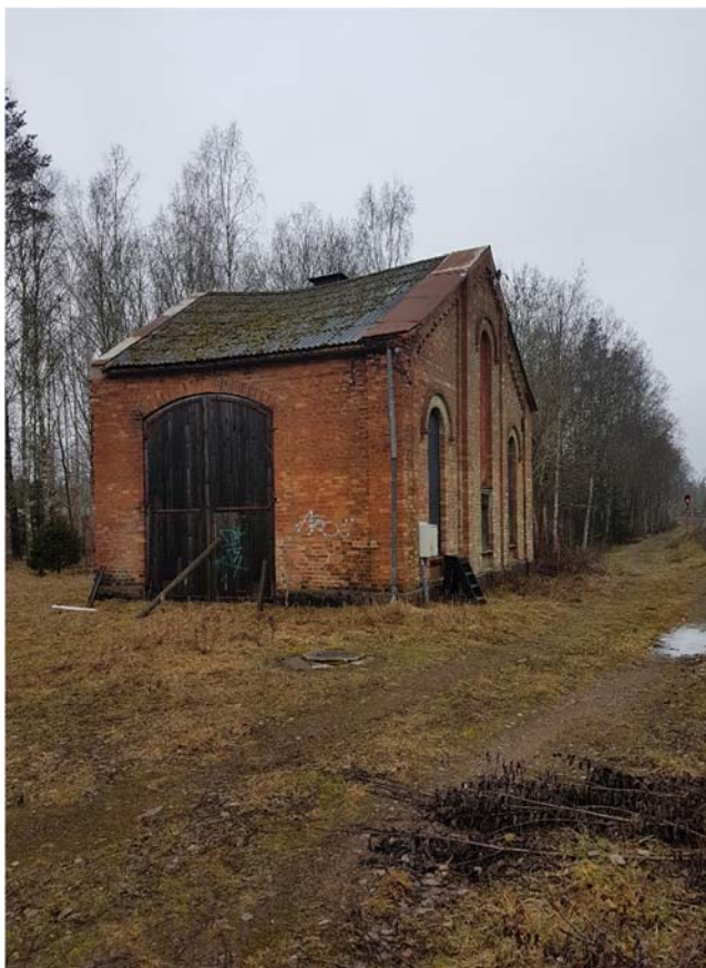
Lokstallet från nordostlig riktning.
