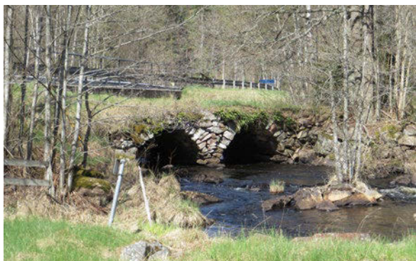
Äldre stenvalvsbro vid Nötebo.
