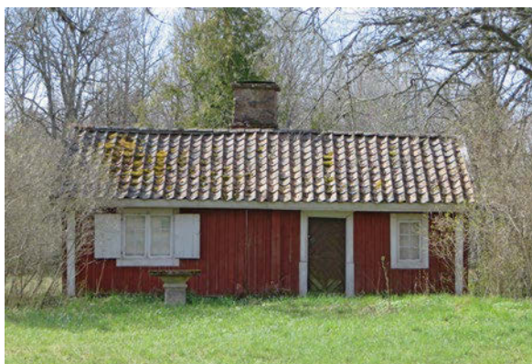
Äldre torp i form av en så kallad enkelstuga. Skorstenen är placerad på bakre takfallet eftersom att taket är ett åstak.
