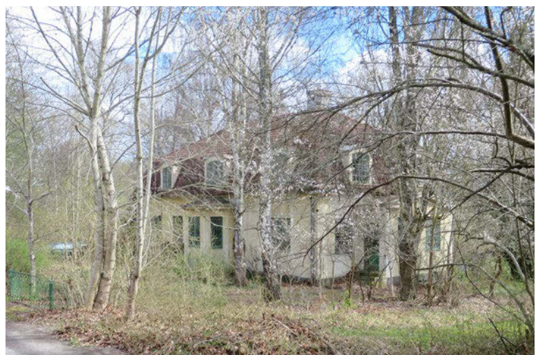
På en tomt alldeles söder om den f.d. folkskolan ligger ett bostadshus (1926) uppfört av landsfiskal Elmin. Huset har originalutförandet bevarat och omges av en större parkliknade trädgård, idag igenväxt.
