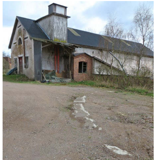
Intill kvarnen ses stenfundament efter den grävda kanal som tidigare gick genom området.
