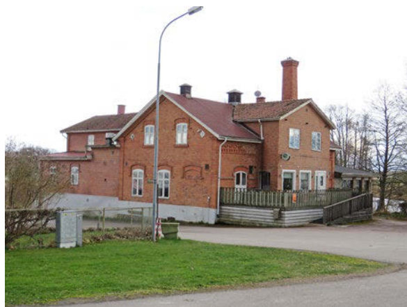
Den f.d. mejeribygnaden, idag restaurang, från 1898 är en förhållandevis välbevarad verksamhetsbyggnad utmed Järnvägsgatan.
