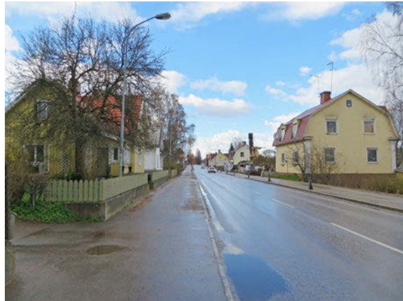
Järnvägsgatans karaktärsförskjutning från villagata till genomfartsled, kan avläsas i bostadsbebyggelsen som ligger tätt intill gatan.
