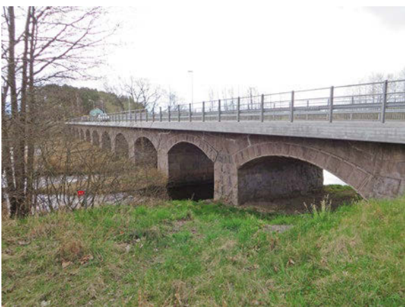
Stenvalvsbron Tingebro med sina tio spann är byggd 1887. Bron har bedömts som en av landets mäktigaste och mest välbyggda stenvalvsbroar.
