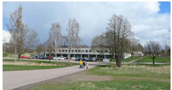
Vårdcentralen ligger i samhällets norra del och är uppförd i slutet av 1960-talet på tidigare åkermark. Byggnaden håller på att byggas till för att även inrymma ålderdomshem.
