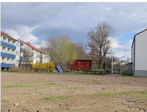
Den f.d. tiondeboden ligger mitt i flerbostadshusområdet. På planen i förgrunden låg fram till 2016 ytterligare ett flerbostadshus.
