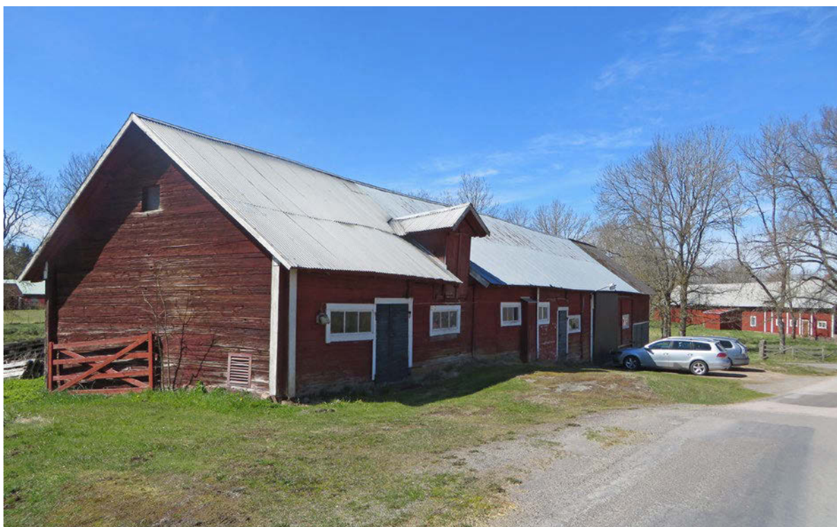
De traditionella faluröda ladugårdarna byggda i skiftesverk har stor betydelse för upplevelsen och förståelsen av byn.
