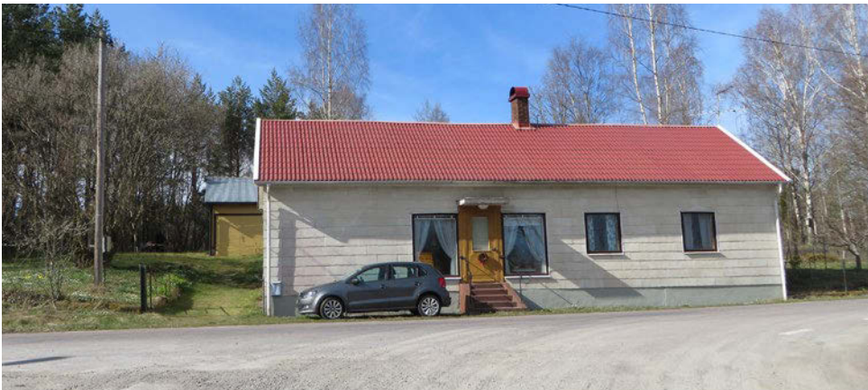
En av de tidigare affärerna (lanthandel) i Horna, som är det första man möts av då man kommer till byarna från Fagerhultshället. Bakom huset det bevarade uthuset, som är en viktig del av den tidigare affärsmiljön.
