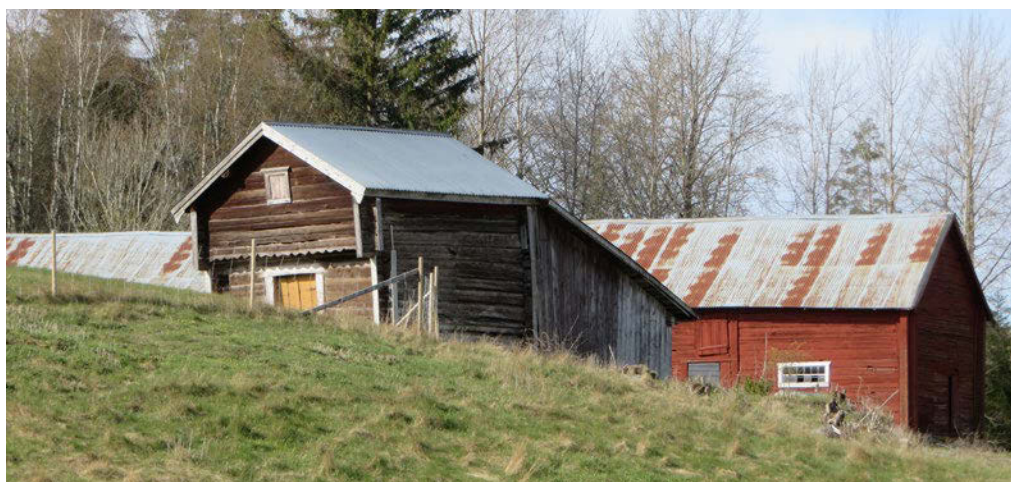
Ladugård i skiftesverk och en äldre bod.
