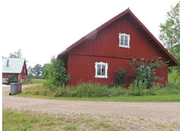
Vagnsskjulet med dekorativt utförda fönster och portar.
