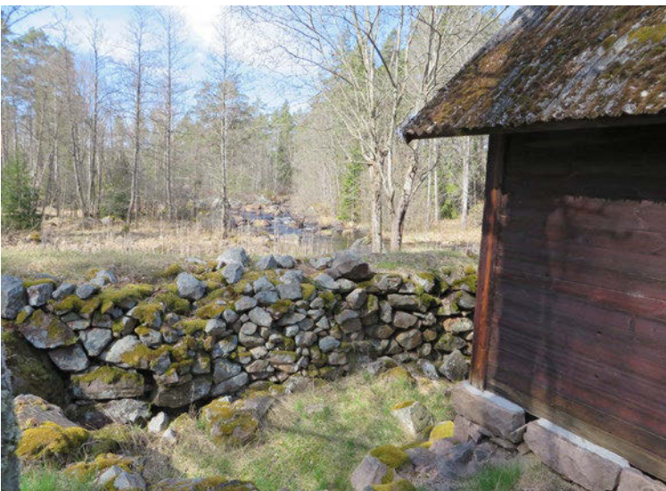
Delar av fördämningsmuren mot den tidigare kvarndammen finns kvar.
