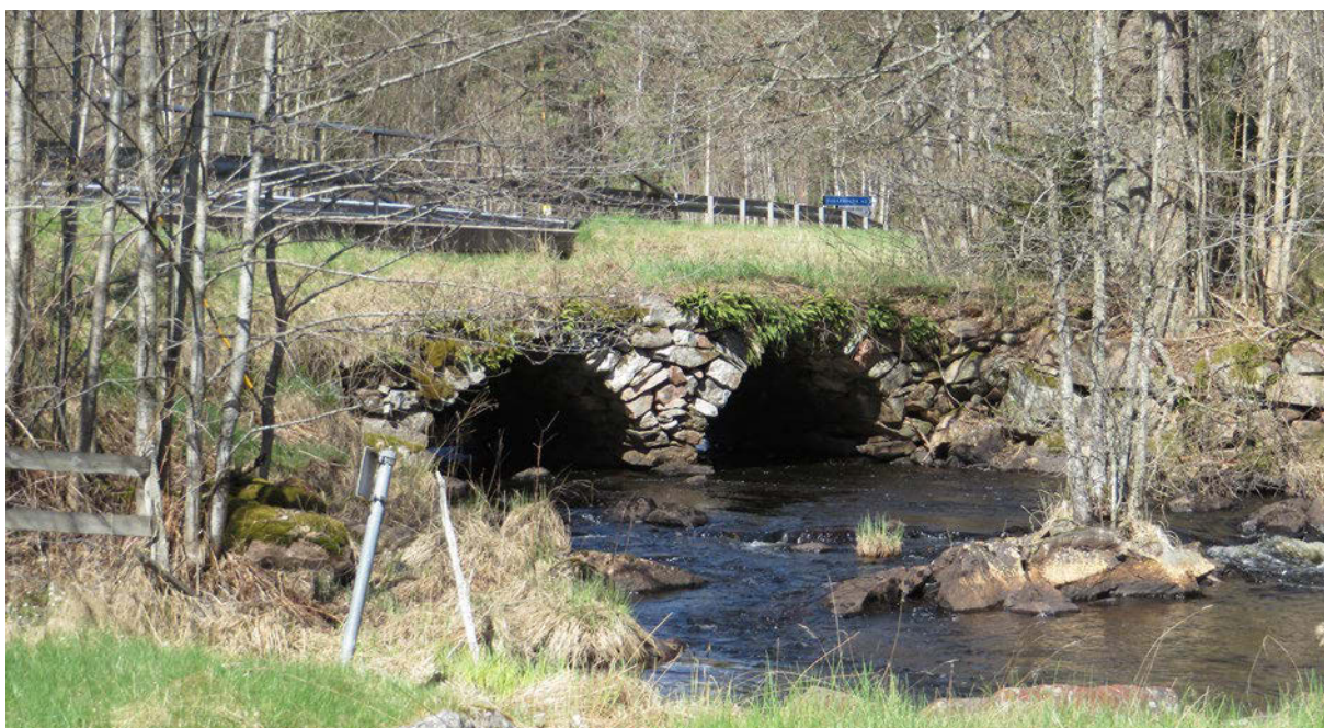
Stenvalsbron över Nötån vid Nötebro. Brons och den intilliggande murens konstruktion äventyras idag av den växtlighet som finns i området.
