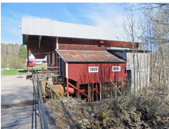
På baksidan finns flera tillbyggnader, f.d. turbinhus och kraftstation. I åfåran ses spår efter kvarnhjulens placering.
