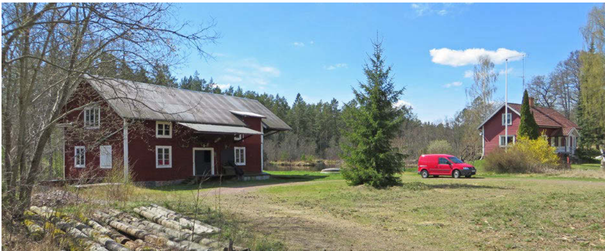
Ljusholms kvarn med tillhörande mjölnarbostad. Planen framför kvarnbyggnaden fylldes upp 1956. Innan dess ledde en backe ned till kvarnens källarvåning.
