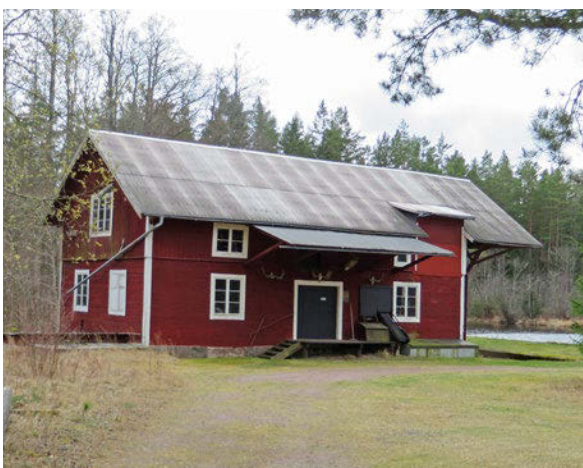
Kvarnbyggnaden är till delar en äldre kvarnbyggnad från sent 1700-tal, men präglas idag av en 1900-talskaraktär.
