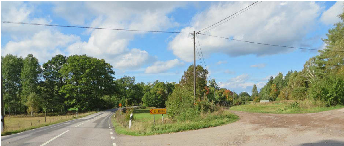
När landsvägen fick ny sträckning i början av 1900-talet fanns den gamla sträckningen kvar. Utmed vägen finns en vällagd stenmur och stammen efter en stor hamlad ask, två värdefulla objekt i vägmiljön.
