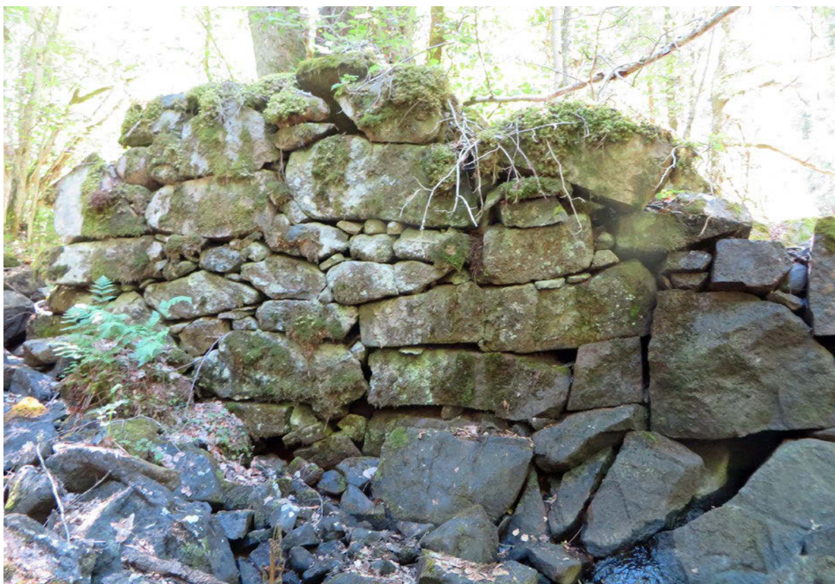
Lämningar efter kvarndammen (dammvallen) vid Triabo kvarn.
