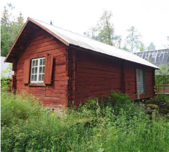
Kvarnbyggnaden är uppförd på 1750-talet och drevs fram till 1934 med vattenhjul, därefter med turbin (vilken finns kvar). Kvarnen drevs främst höst, vinter och vår när vattenflödet var som störst. Kvarnen var i drift fram till 1970-talet och renoverades år 2000.
