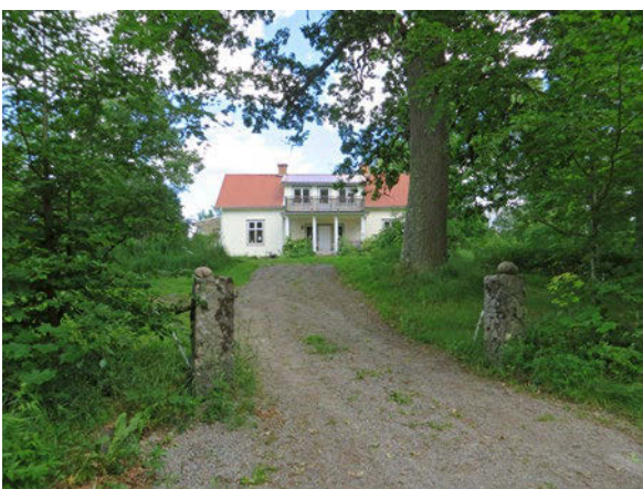
Mangårdsbyggnaden vid Liskatorp har genomgått flera sentida ombyggnader.
