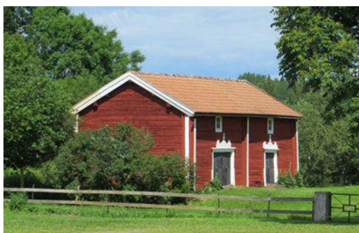
Den timrade dubbelboden utmärker sig med sina ålderdomliga dörrar med dekorativa omfattningar av barocktyp. Boden har tidigare haft en vällingklocka.
