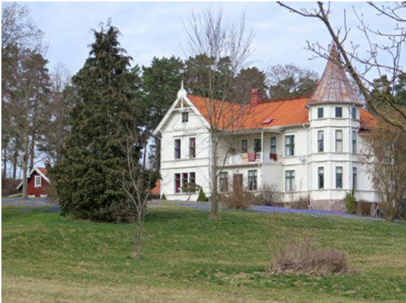
Huvudbyggnaden har kvar sin utmärkande ursprungskaraktär och ger genom sin utformning och läge ett pampigt intryck.
