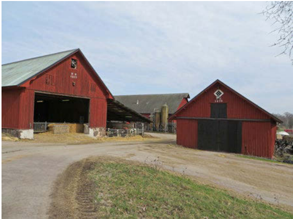
Den södra och västra längan kring gårdsplanen är också uppförda under sent 1800-tal.
