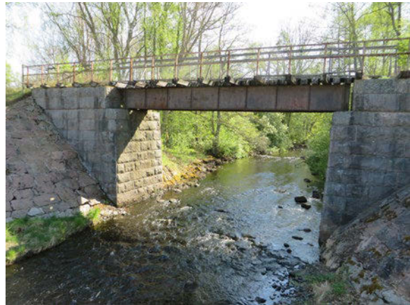
Järnvägsbron över Badebodaån.
