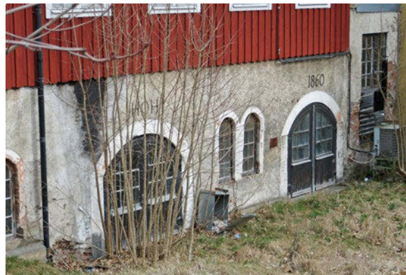
Initialerna och årtalet på smedjans putsade stenvägg anger att byggnaden uppfördes 1860, då Henrik Otto af Harmens ägde bruket. Smedjan byggdes på med en våning under 1920-talet.
