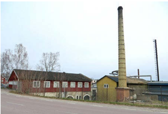
Två äldre byggnader inom fabriksområdet, ursprungligen uppförda som manufakturmedja och ångpannhus.
