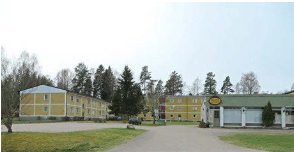
Intill Bruksgatan ligger ett område med flerfamiljhus från tidigt 1960-tal med en lägre affärslänga ut mot gatan.
