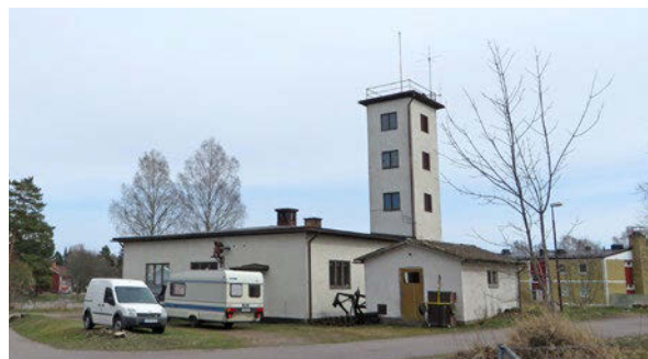
Den f.d. brandstationen med sitt karaktäristiska slangtorn utgör en märkesbyggnad på orten.
