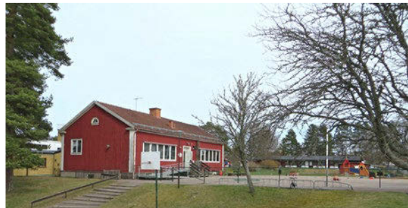
Den äldsta skolbyggnaden vid Fågelfors skola är uppförd på 1940-talet.
