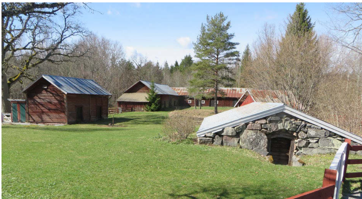
En av två mycket välbevarade ålderdomliga gårdar i byn Tränsjömåla, på den medeltida bytomtens läge. Välbevarad man-gårdsbyggnad (uppförd före 1843) av parstugetyp med ekonomibyggnader och stenkällare kring en götisk gård.
