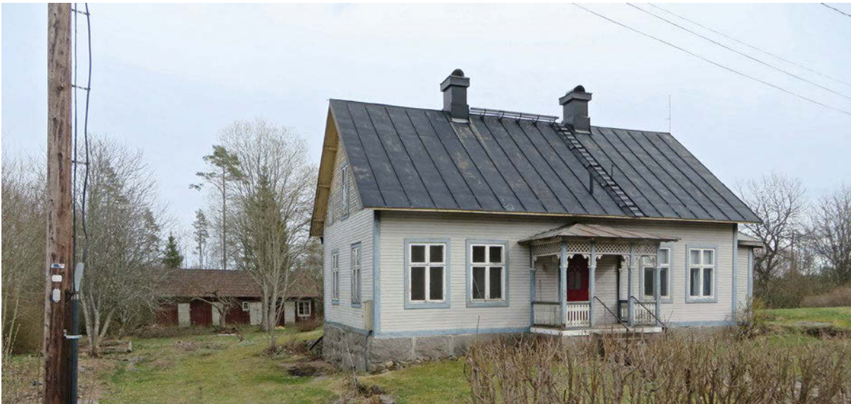
Här finns också exempel på äldre gårdar. Hustyp med fönster av 1890-talstyp samt falsat plåttak.
