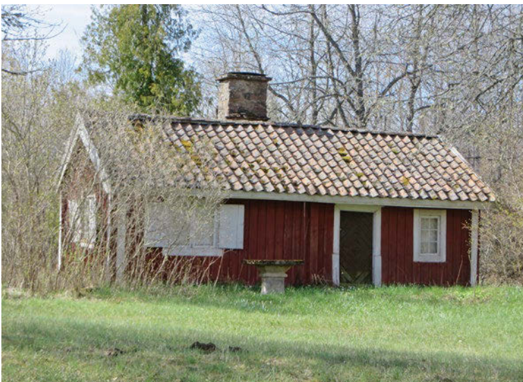
En av de äldsta stugorna (troligen från 1700-talet), med ryggåstak (ryggåsstuga) och lertegeltak.
