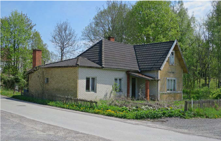
Björkshults stationshus (1916) präglas idag till viss del av en ombyggnad på 1960-talet. Spåren revs bort strax efter järnvägens nedläggning.
