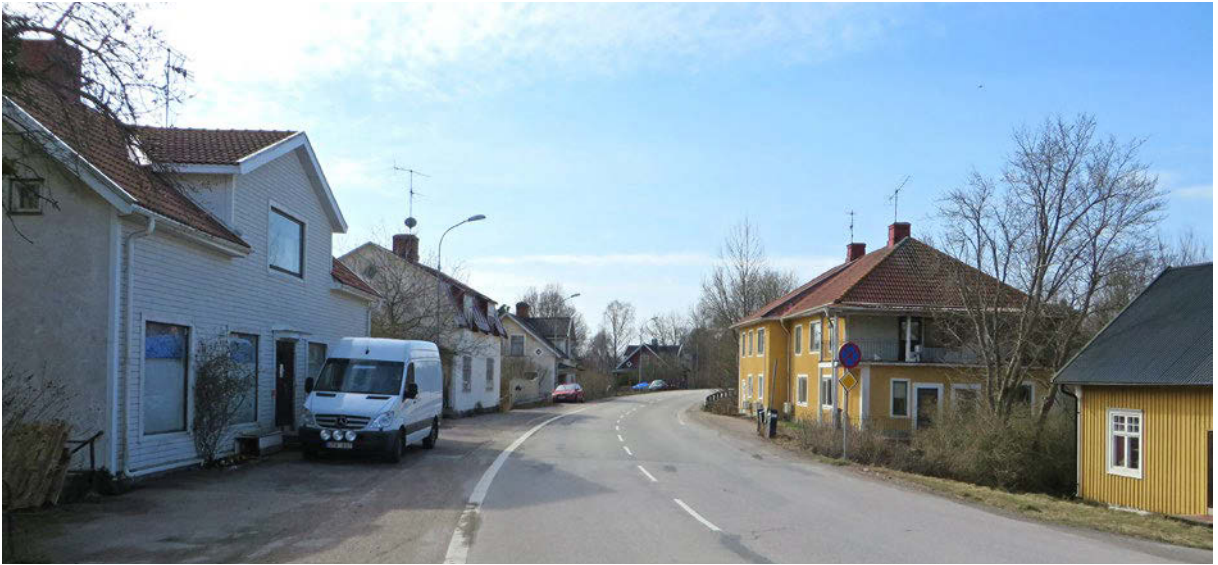
Södra Storgatan sedd från järnvägsbron med affärs- och bostadsbebyggelse från 1900-talets första hälft. Gatan följer åsens tydliga höjdrygg. Husen ligger tätt intill gatan på sluttande tomter.
