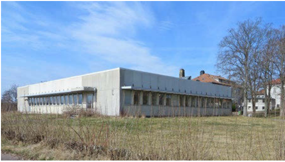
Badhus- (1980) och konferansanläggningen (1972) är sammanlänkade med den södra flygeln.
