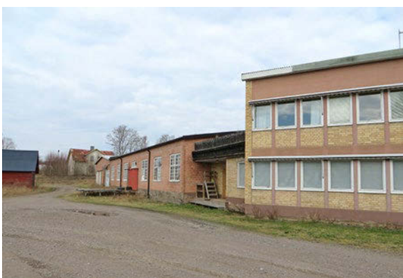
I industrimiljön återfinns såväl äldre som sentida fabriksbyggnader från Berga snickerifabrik.
