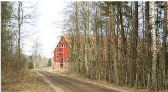
Vid vägen ligger den stora ladugård som uppfördes på 1940-talet sedan sjukhemmet även köpt in jordbruksfastigheten.
