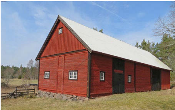
Ytterligare en ladugård tillhörande den östra gården återfinns på andra sidan byvägen. Även denna är i skiftesverk.
