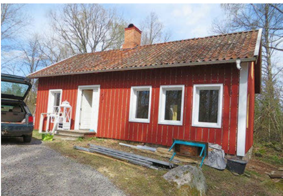
Torpet Kalvhagen från tidigt 1800-tal är det enda kvarvarande torpet som låg i området för Bondeberga by. Huset är dock kraftigt förvanskad och samtliga ekonomibygnader är rivna.
