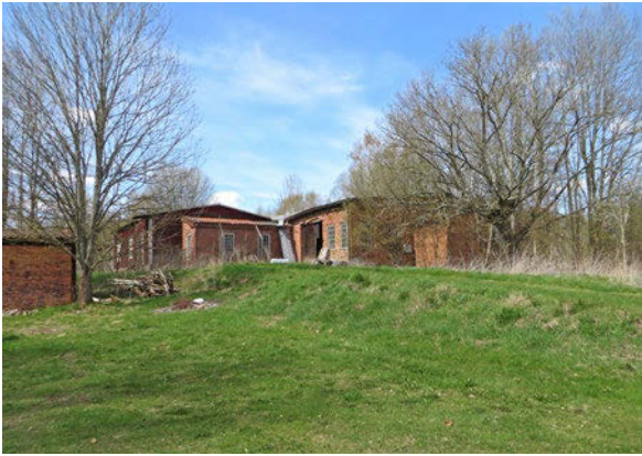
Delar av de äldre produktionsbyggnaderna finns ännu kvar.
