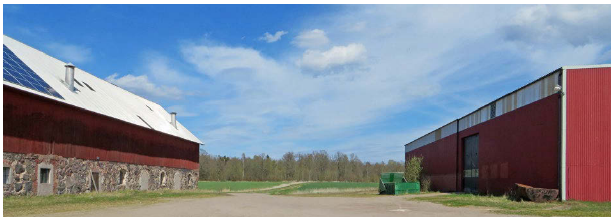
Gårdsplanen med stenladugården och en modern plåthall.
