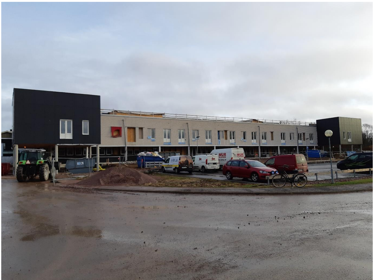
Ombyggnad av Mogården till trygghetsboende, pågående projekt (foto 2019-01-07)
