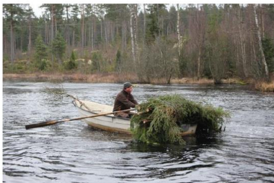
Figur 14. Ris läggs ihop med stålband eller nät och placeras på botten varefter störar trycks ner i botten och förankrar rispaketet. Foton: Carl-Johan Månsson
