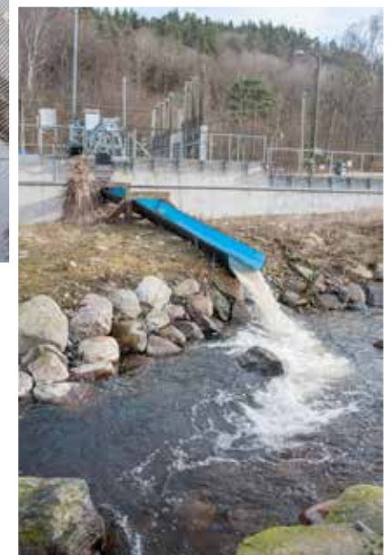
För nedströmsvandringen finns ett galler framför turbinintaget med flyktöppningar där fiskarna kan smita in. De hamnar då i en ränna som mynnar i omlöpet där fiskarna kan fortsätta sin nedströmsvandring utan hinder.
