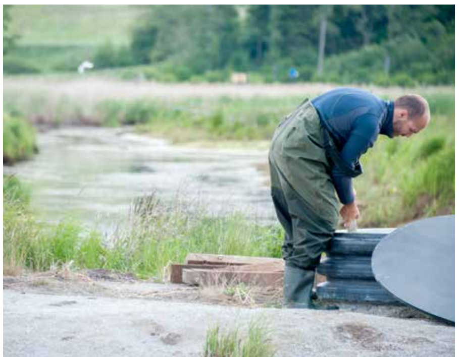
Nivån i våtmarken regleras med en munk där tröskeln för utloppet kan höjas och sänkas
