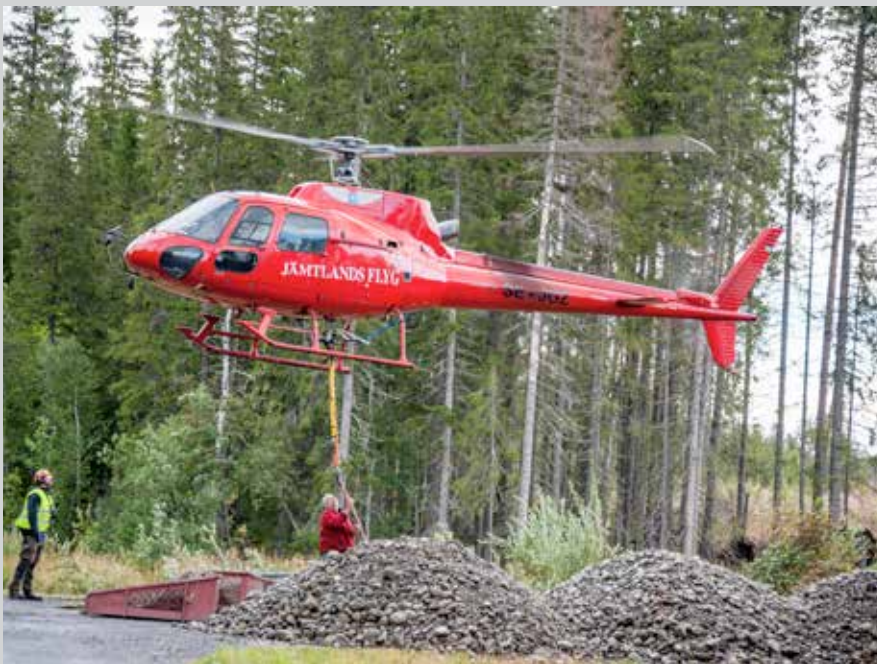
Helikoptern hämtar lekgrus som lagts upp vid väggkanten nära älven.
