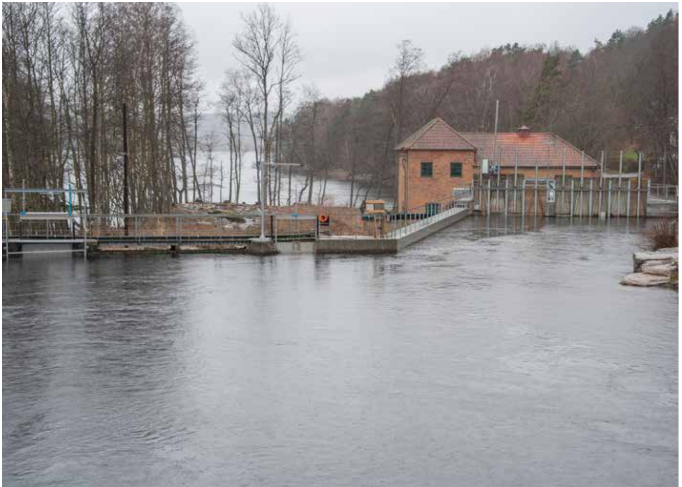
Ålgårda kraftverk var tidigare det nedersta definitiva vandringshindret i Rolfsån. Nu kan lax och havsöring passera och ta sig minst fyra mil upp i ån för att leka.
