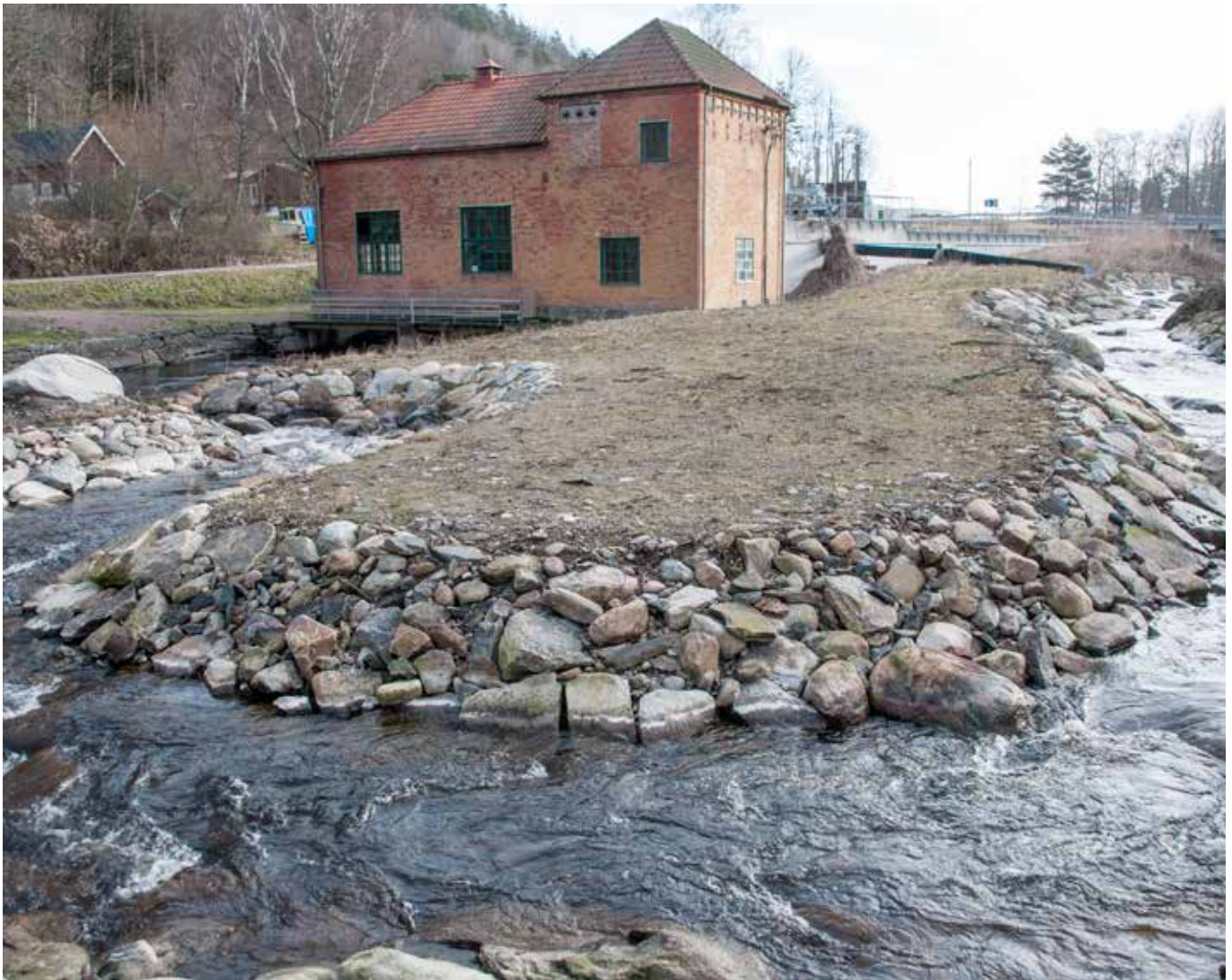
1,4 kubikmeter vatten per sekund rinner genom omlöpet och det motsvarar en flödesförlust genom turbinen vid Ålgårda kraftverk på i genomsnitt 13 procent.
