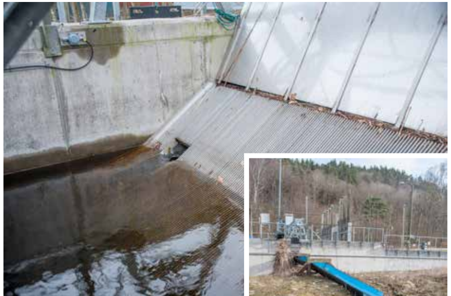
För nedströmsvandringen finns ett galler framför turbinintaget med flyktöppningar där fiskarna kan smita in. De hamnar då i en ränna som mynnar i omlöpet där fiskarna kan fortsätta sin nedströmsvandring utan hinder.
